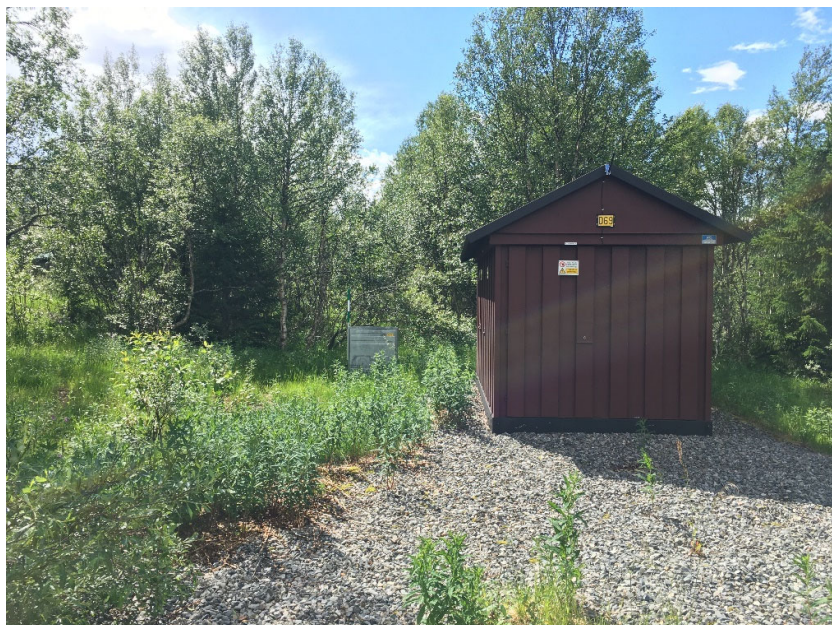
Figur 10. Foto av transformatorstation.
