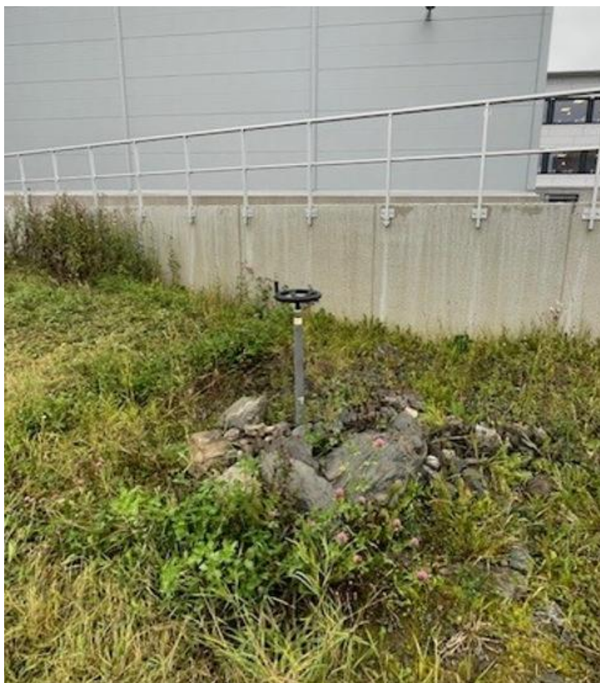
Figur 8. Avstängningsventil vid dagvattenkassett i områdets sydöstra del.
