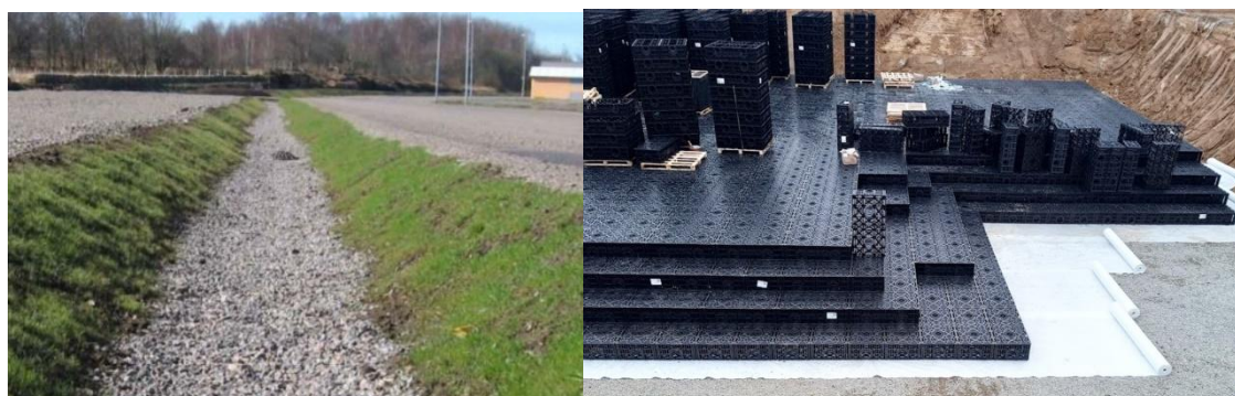
Figur 14. Krossdike (t.v) och kassettmagasin (t.h)
