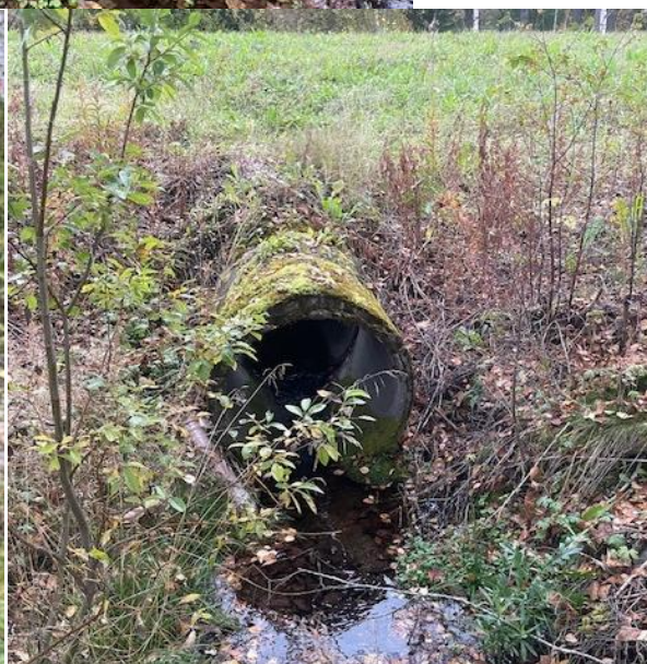
Figur 10. Dike 2016 som rinner genom området leds via trumma under väg 321 (bild från platsbesök).
