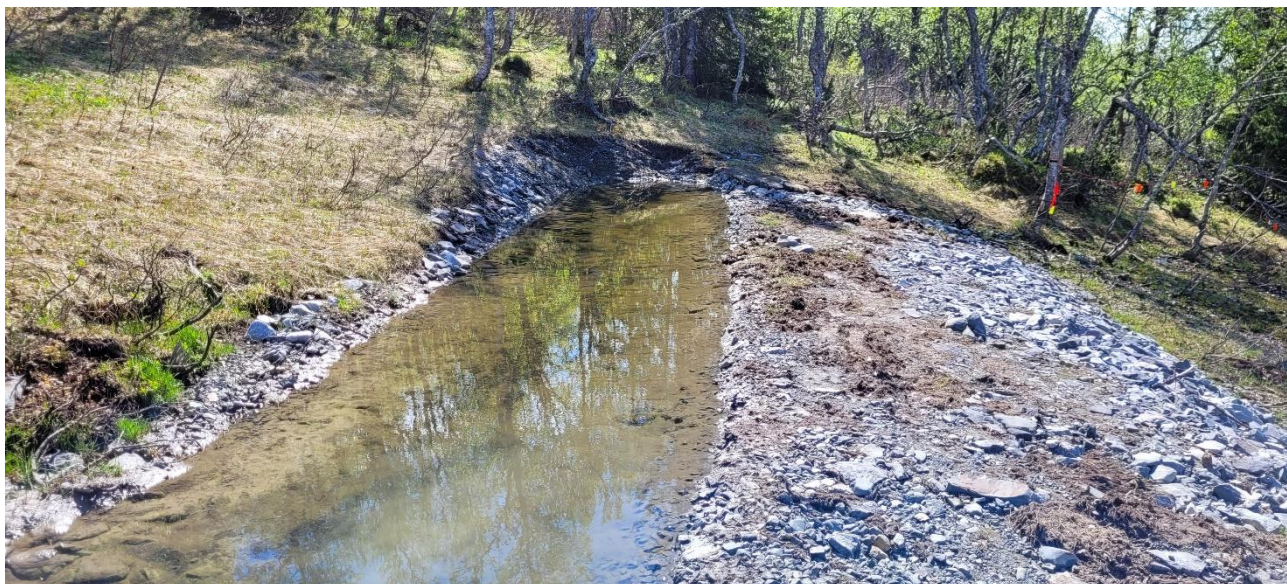
Figur 13. Exempel på sedimentfälla/fördröjningsåtgärd genom tillskapande av vall.
