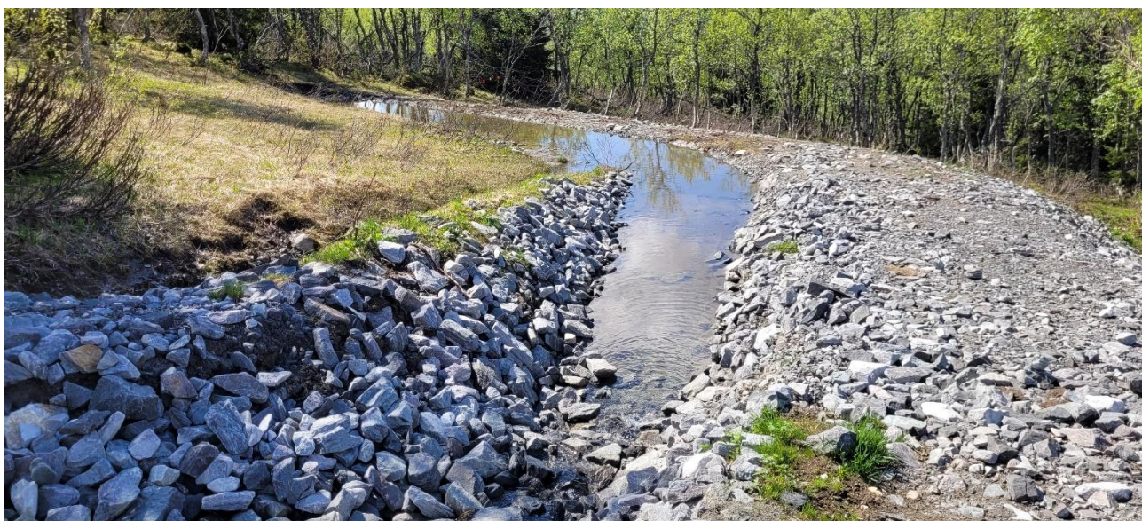
Figur 14. Exempel på sedimentfälla/fördröjningsåtgärd genom tillskapande av vall.
