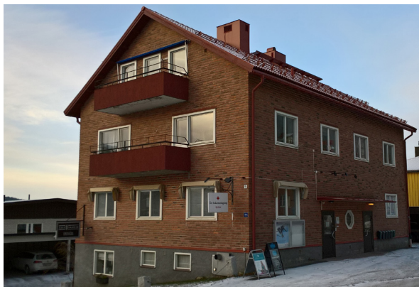
Mörviken 2:50 uppfördes mellan åren 1945-1956. Byggnaden innehåller en större bostad och tre lokaler.
