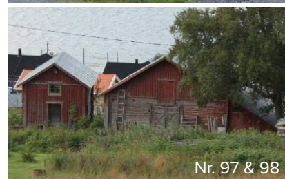
Figur 9. Äldre lador och härbren med kulturmiljövärde. Foto: Jamtlis byggnadsinventering från 2017
