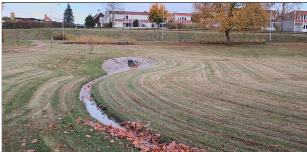
Figur 24. Exempelbild över en torrdamm med möjlighet för temporärt stående vattenyta (SVOA, 2022).
