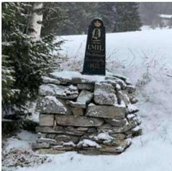
Milstolpe i gjutjärn på kallmurat naturstensfundament. Den nya landsvägen tillkommen under 1800-talets mitt hade en ny standard på 6 meters bredd att jämföra med S:t Olavsledens 3 meter.
