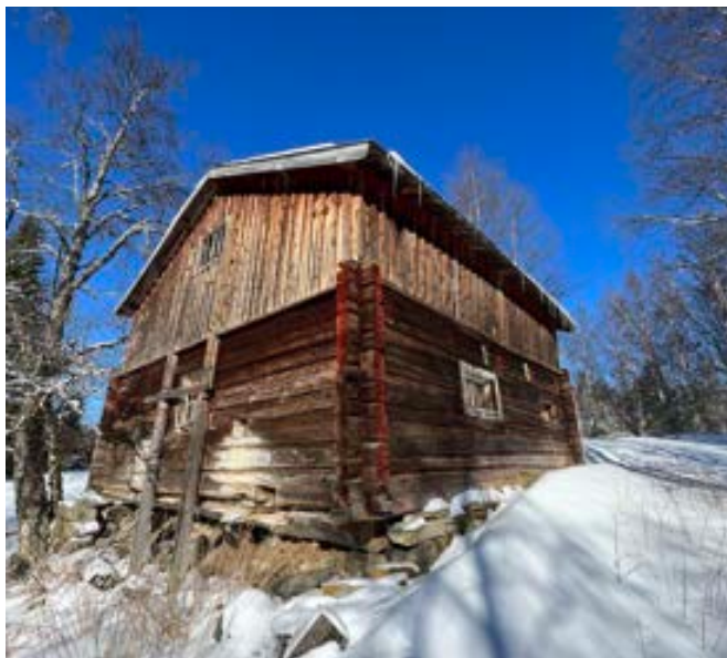
1800-tal. Hållen gård. Ekonomibyggnad i ålderdomligt utförande med timrad rödfärgad fasad och synliga knutar, och ovandel i stående omålad locklistpanel. Kallmurad sockel av natursten. Vitmålade fönster och vindskivor. Sadeltak täckt av lertegel.
