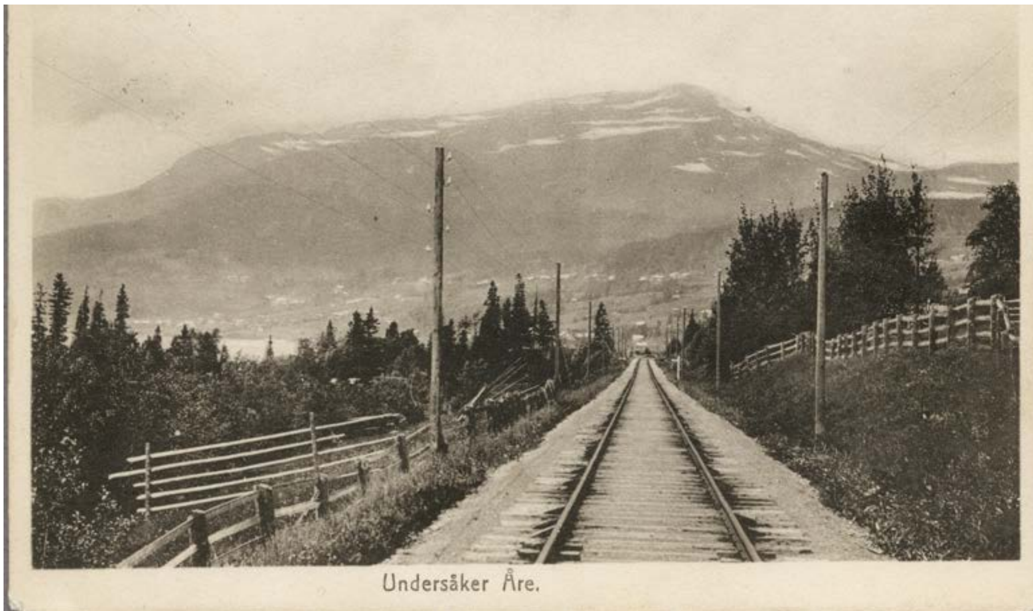
Fotografi från järnvägen genom Undersåker, taget år 1910. Källa: Järnvägmuseet.
