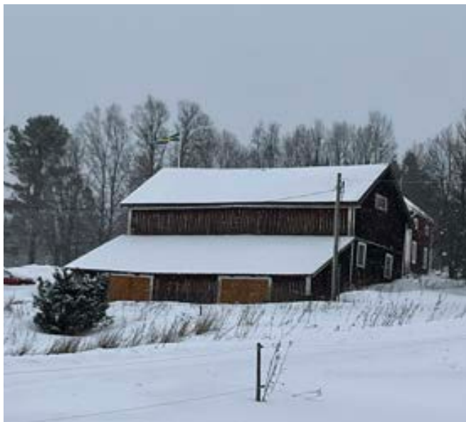
1900-1920. Västigårn och Ersgården. Rödmålad ladugård med stående locklistpanel. Vitmålade äldre träfönster och vita knutar samt vindskivor. Bevarade dubbelportar målade i gul kulör. Sadeltak täckt med bandplåt.
