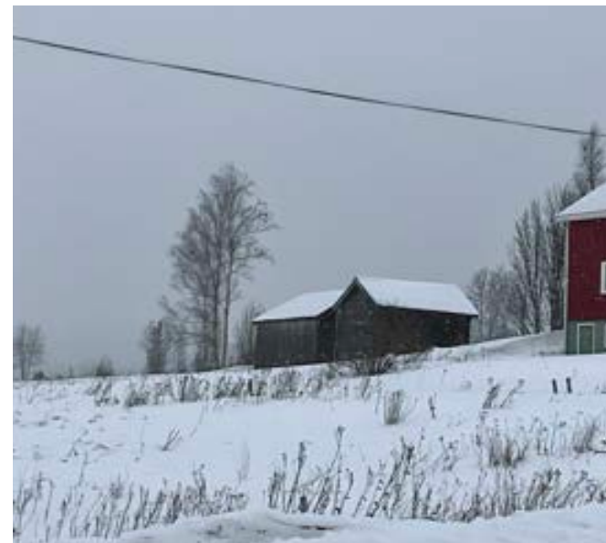
1800-tal. Uthusbyggnad. Västigårn och Ersgården. Omålad timmerbyggnad med sadeltak täckt i plåt. Viktig del av gårdsmiljön.
