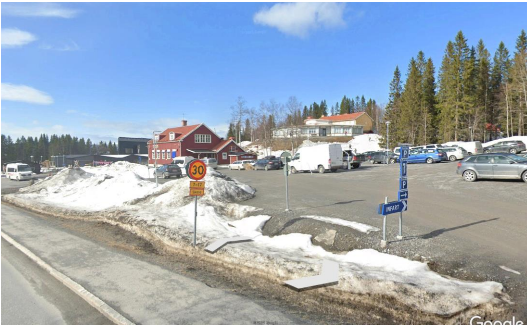
Figur 2. Streetview tagen i nordvästlig riktning från Byvägen. Befintlig nybyggd skola syns i bilden.
