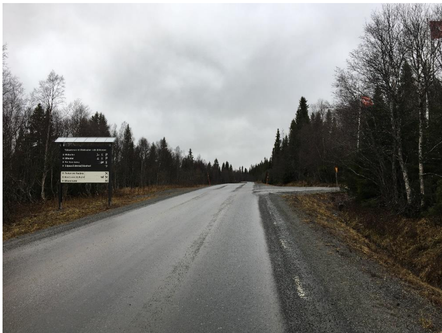
Figur 55 - Befintlig entré till Rödkullens centrum. Vägbelysning saknas i dagsläget trots stundtals höga trafikflöden. Bild från platsbesök.
