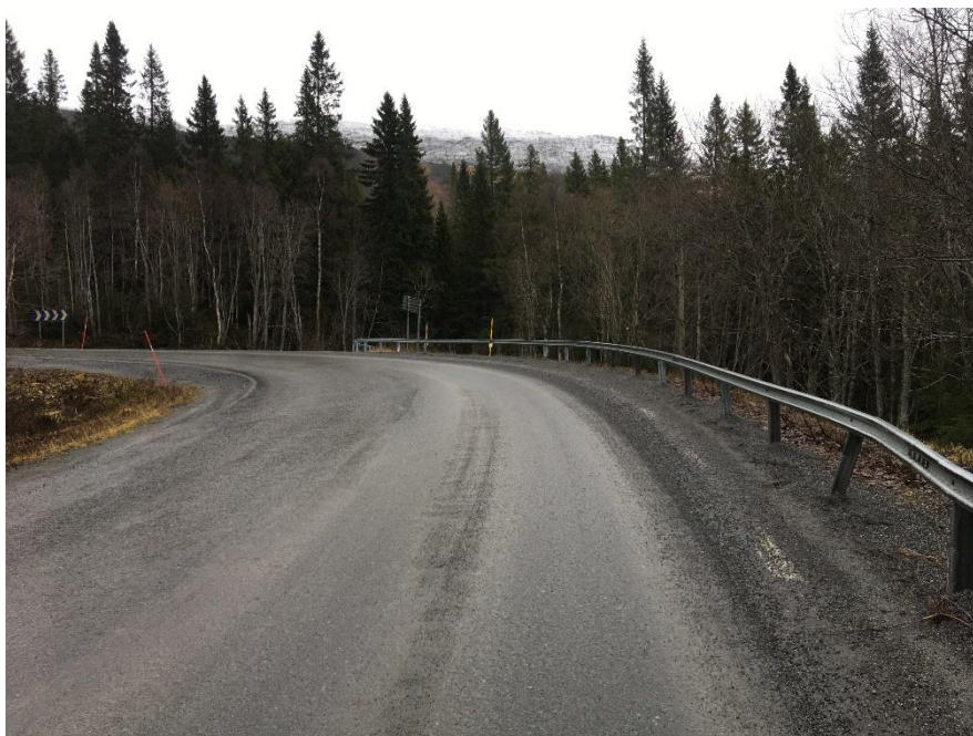
Figur 56 - Kurva vid föreslagen daggästparkering 4. Vägräcke visar tecken på kollisioner. Bild från platsbesök.
