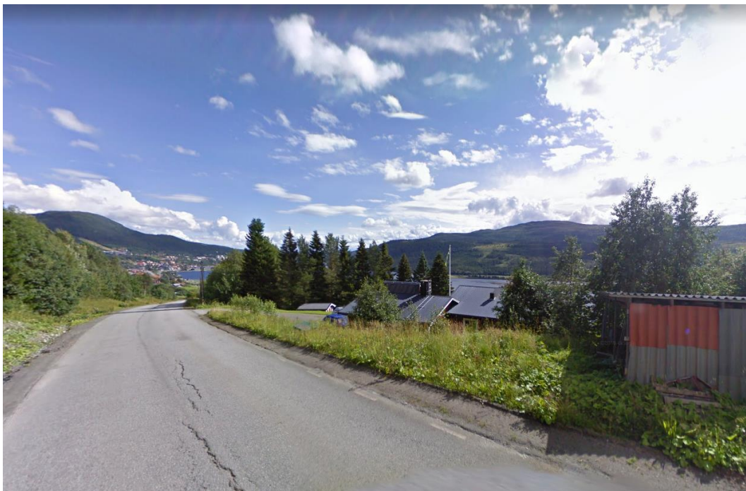
Figur 57 - Avsaknad av skyddsanordning vid bostadsbebyggelse. Bild från Google Maps, augusti 2010.
