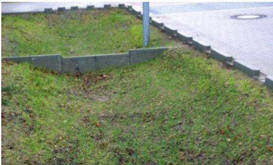
Figur 63. Svackdike med hinder för att tillåta vattnet att stanna upp och infiltrera.
