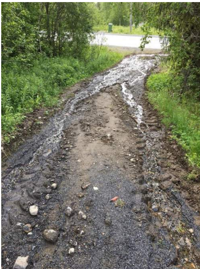
Figur 70. Exempel på tillfällig körväg i Rödkulleområdet där vatten tränger fram i hjulspåren.
