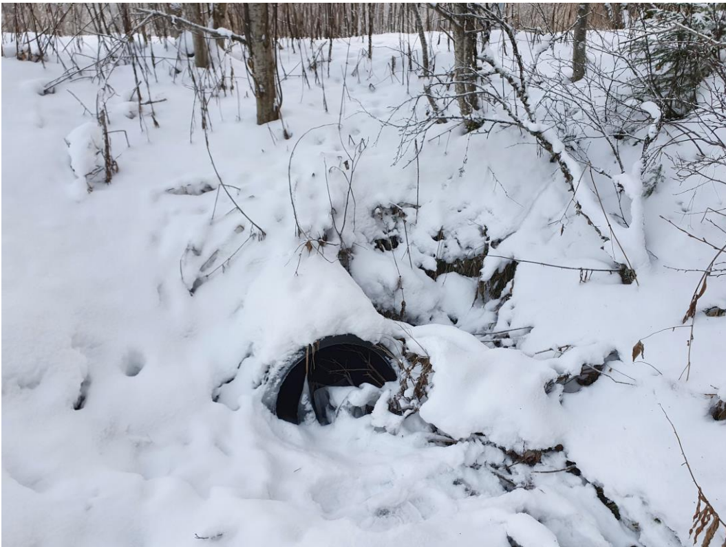
Figur 11. Dagvattentrumba genom Karolinervägen som obesörjer den östra bäckfåran. Dimension 600 mm.
