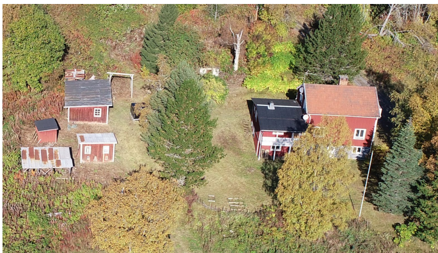
Bild 9. Befintliga byggnader som avses rivas på fastigheten Mörviken 1:4.
