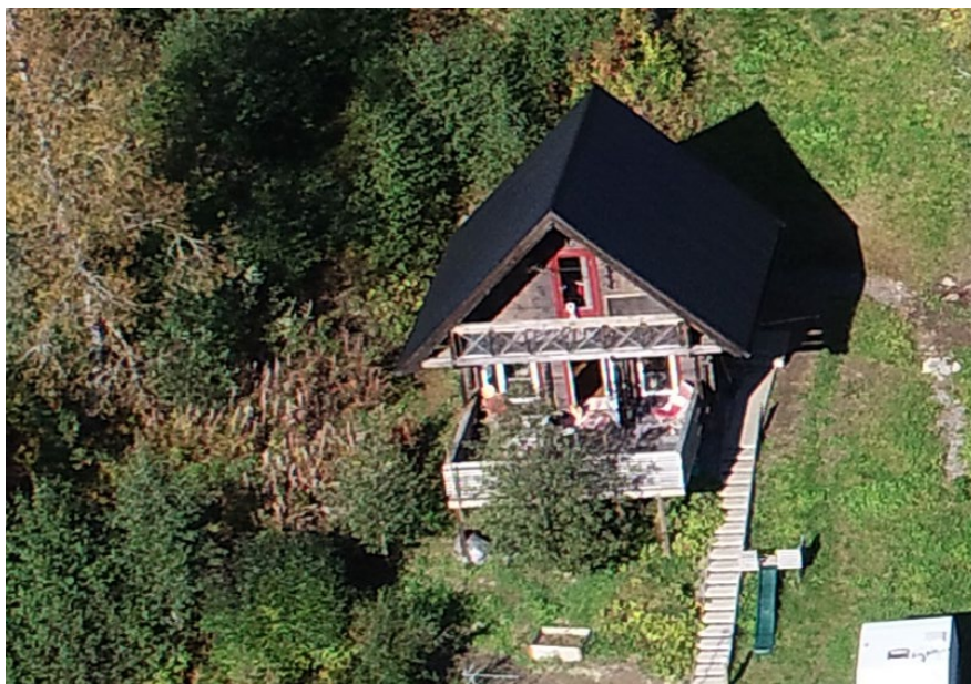
Bild 11. Fastigheten Mörviken 1:135, belägen i västra delen av planområdet
