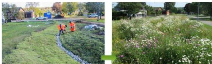
Figur 15 Exempel på svackdike uppbyggt med fuktängsmattor vid anläggning och efter 1,5 år. Bildkälla: vegtech.se.
