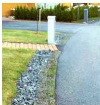
Figur 17. Exempel och principskiss på kross-/makadamdike.
