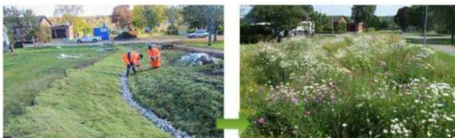
Figur 19. Exempel på svackdike uppbyggt med fuktängsmattor vid anläggning och efter 1,5 år. Bildkälla: vegtech.se.
